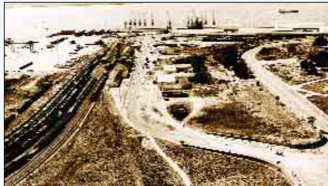
Vista do porto, e parte da linha férrea no Corredor do Desenvolvimento de Nacala.
