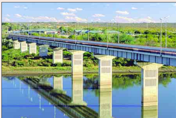
Infraestruturas de pontes como esta sobre o rio Limpopo facilitam o movimento de pessoas na região.
