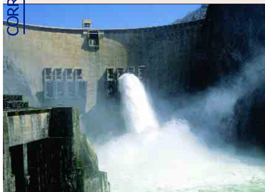
Barragem de Cahora Bassa no corredor do Zambeze é uma grande fonte de energia hidroeléctrica para a região.
