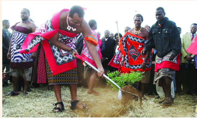
Rei Mswati III cavando o solo para marcar o início oficial dos trabalhos da construção do parque de férias de Jozini, ao longo da Iniciativa de Desenvolvimento Espacial de Lubombo
